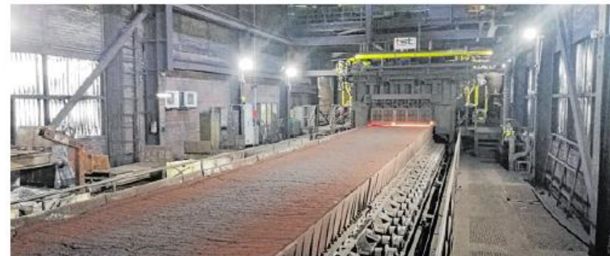
In der Sinteranlage wird Material für den Hochofenprozess vorbereitet. Und das funktioniert jetzt mit Gichtgas.
