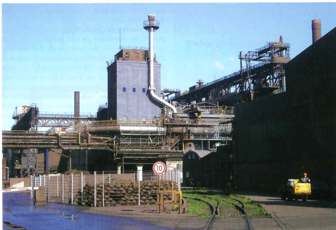
1 Blast furnace plant of DK Recycling und Roheisen GmbH
